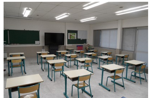
Fin des travaux de rénovation d'une classe
