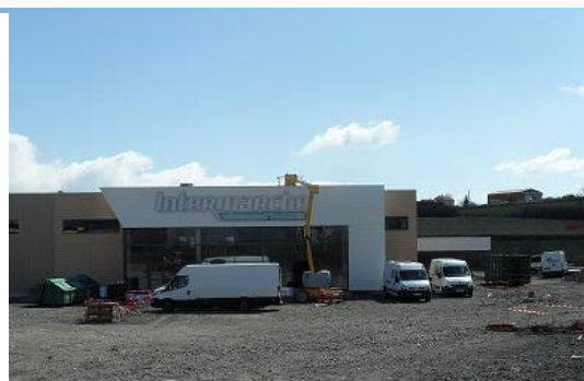
Travaux en cours
