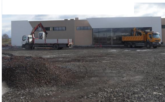
Travaux en cours
