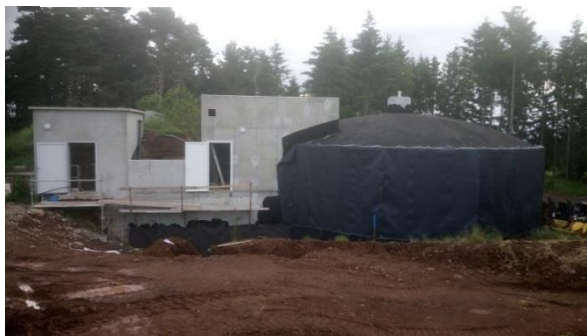
Travaux en cours
