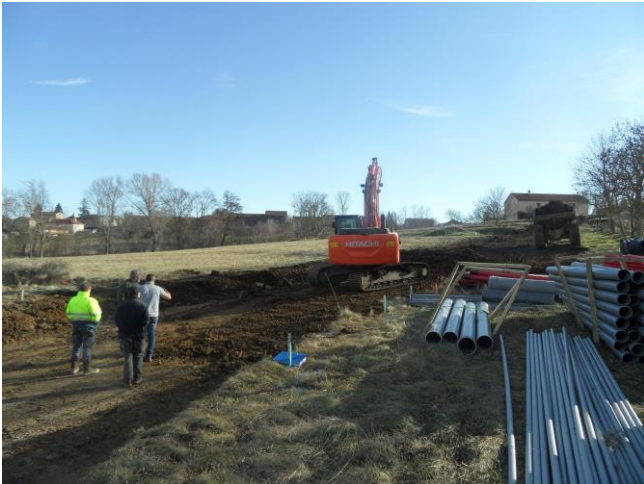
Travaux en cours
