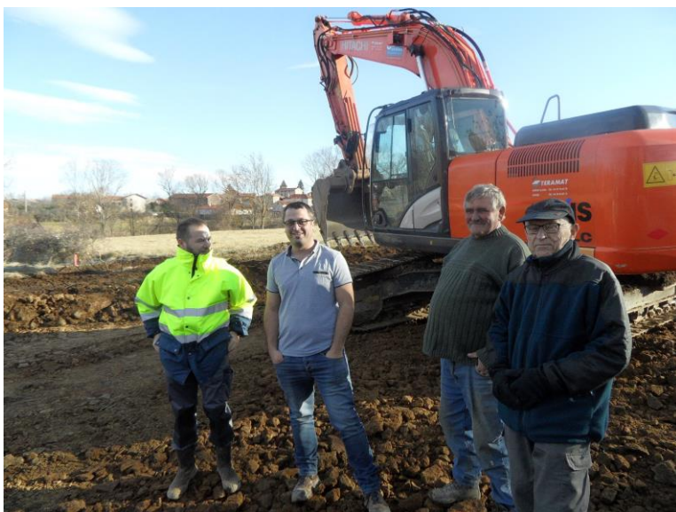
Réunion de chantier en présence de Bernard Giraud.
