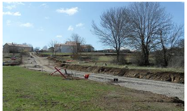
Travaux en cours
